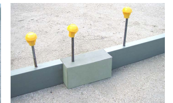
寸法調(スリットライナー使用)整
